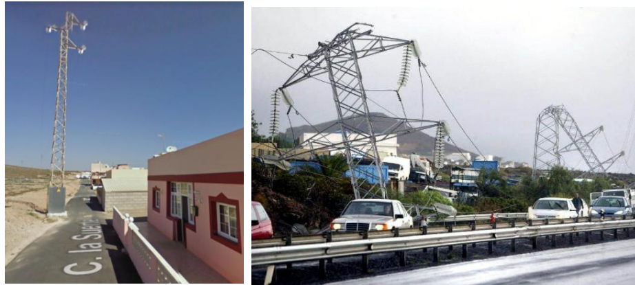
Figura 36. Torre de alta tensión localizada en la calle la Suerte (izq) Fotografía: https://www.google.com/maps(2011) ; Ejemplo. Caída de colapso de torre de alta tensión por fuertes vientos, Tenerife. Fotografía: https://www.diariodeavisos.com
