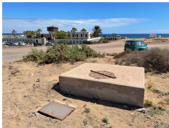
Figura 40. Pozo de registro y arqueta. Fuente: Elaboración propia.
