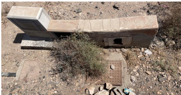
Figura 37. Arquetas y contadores en el Paseo Marítimo. Fuente: Elaboración propia.
