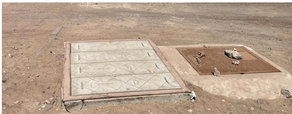
Figura 46. Arqueta de telecomunicaciones. Fuente: Elaboración propia.
