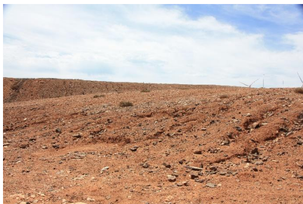
Acarcavamientos sobre los taludes antrópicos del noreste del ámbito.
