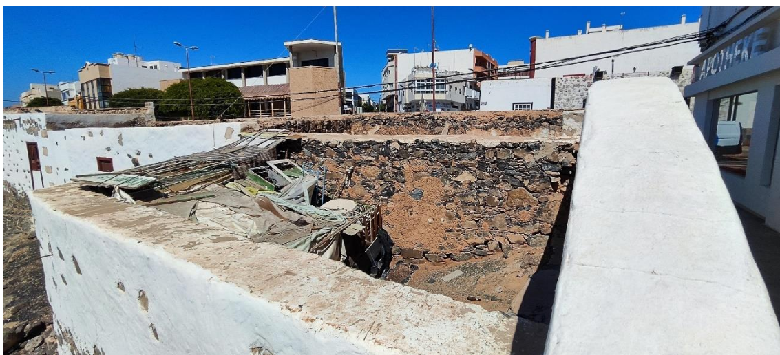
Figura 34: Cubierta derruida en el ámbito de estudio.
