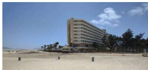
Vista general de la zona de instalación de elementos
