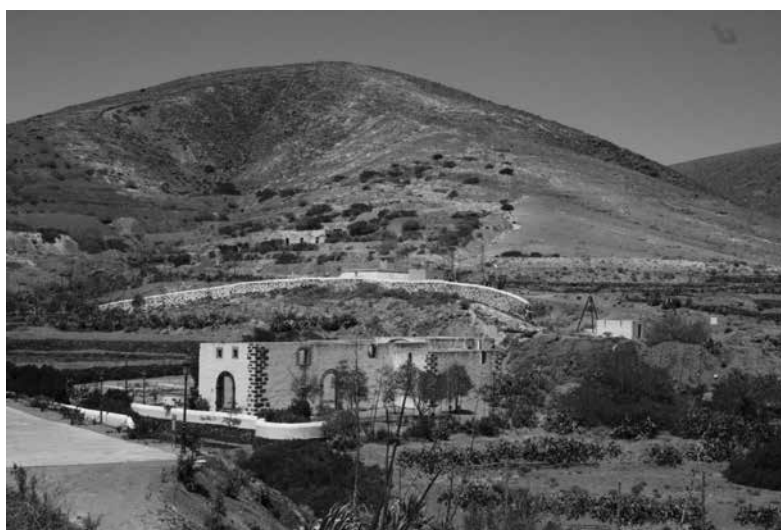
Fig. 2. Vista general del convento, según los fondos fotográficos de FEDAC. Imagen fechada en 1895.
