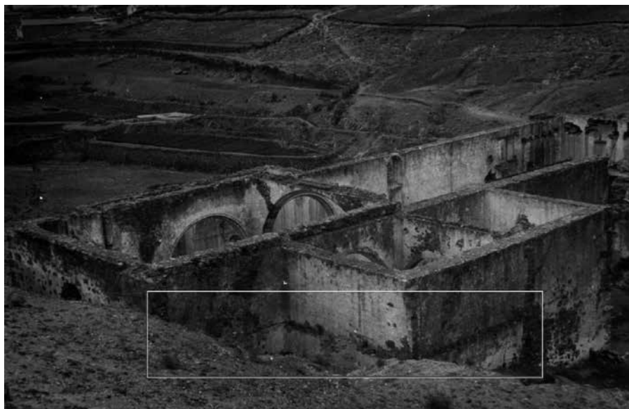
Fig. 11. Vista de la zona conventual desde el noreste. Marcado en negro la galería alta de la sacristía y espacios aledaños (Fondo fotográfico Miguel Tarquis).
