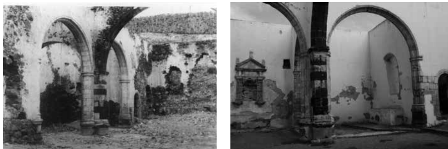
Fig. 17. Estado de la nave central y capillas del evangelio, antes y después de las obras de Roldán Verdejo en los años 60.
