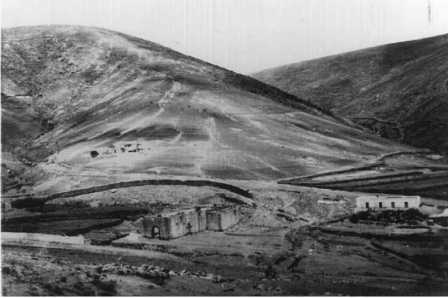
Fig. 22. Zona exterior hacia el sur de la zona conventual.
