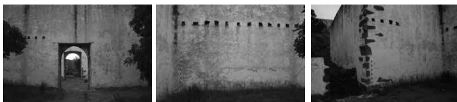
Fig. 13. Lienzo sur de la zona conventual en la actualidad y detalles de las marcas de las vigas que sustentaron la parte alta.
